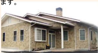
平成23年11月に完成した保育室
